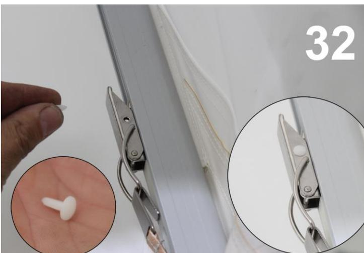
Drücken Sie die weiße Spreizniete [aus dem Beipack der Membrane] in die Lochaufnahme des Verschlusshebels hinein (1 Spreizniete je Verschluss).
