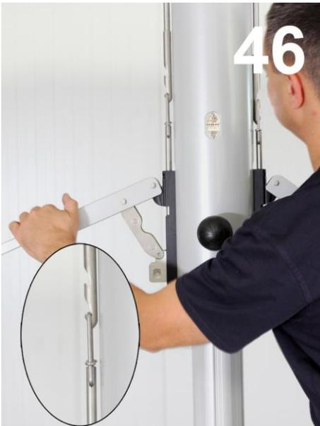
Belassen Sie den **rechten** Spannhebel in etwa in der im Bild gezeigten Position und öffnen anschließend den **linken** Spannhebel, um .....
