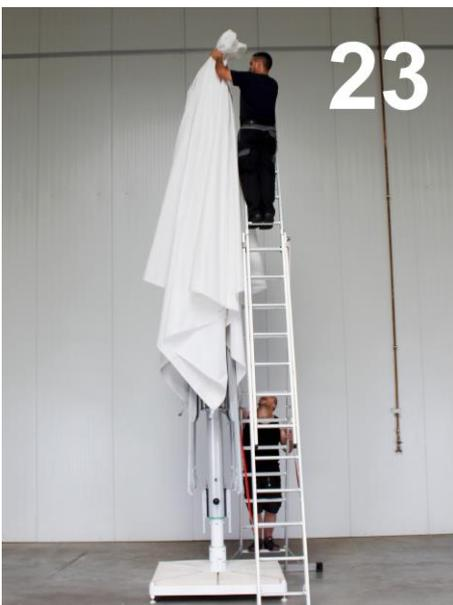
Fassen Sie die Membrane – wie im Bild gezeigt – zusammen, ziehen Sie sie in mehreren Schritten nach oben, so dass Sie sie schließlich in Gänze über die Gestellspitze hinweg abziehen können, um sie .....
