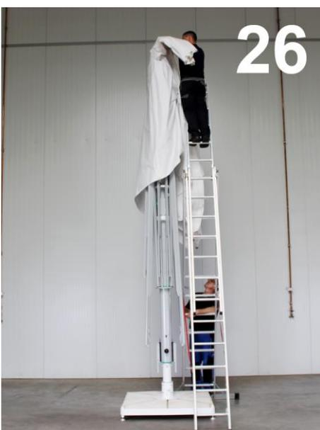
Mit dem Membranpack auf Ihrem Arm gehen Sie auf der Leiter wieder nach oben in eine Position, in der Sie den Pack entfalten, d.h. handhaben und feststellen können, wo sich das Kopfende mit den dicht beieinander liegenden (oberen) Membranhaken befindet. Das andere Ende ziehen Sie so weit nach oben, bis Sie eine der äußeren Dachkanten der Membrane zu fassen bekommen. Stülpen Sie sie über die Gestellspitze hinweg.
